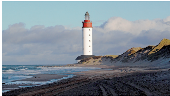
Anholt Fyr – opført 1785-1788 og forhøjet 1881.
